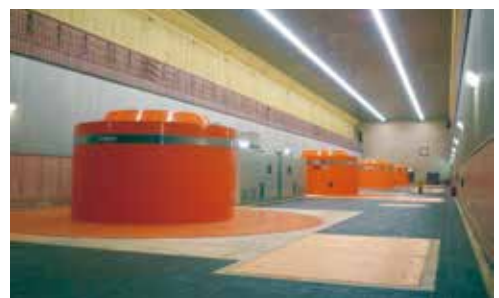
▲地下発電所内部
