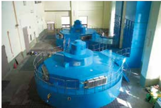
▲津久井発電所
