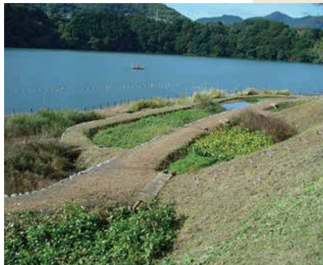
三井植物浄化施設▶
