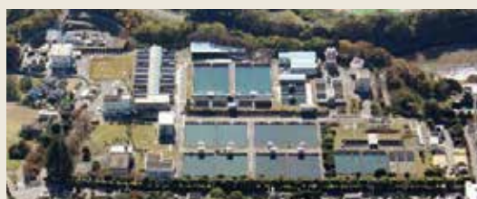
◀谷ヶ原浄水場
