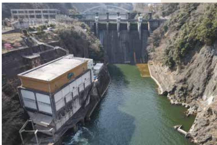
▲相模ダムと相模発電所
