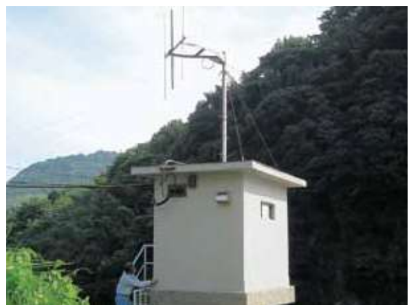
うりょう すいりょう 雨量や川の水量のデータをダムに送る むせんそうち 無線装置の点検をします。
