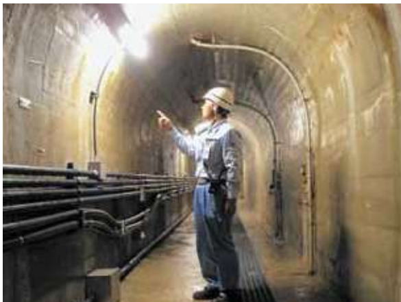
ダムを安全に守るため、トンネル内の点検をします。
