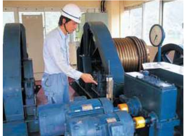
ゲートを動かすために せつび てんけん 設備を点検します。
