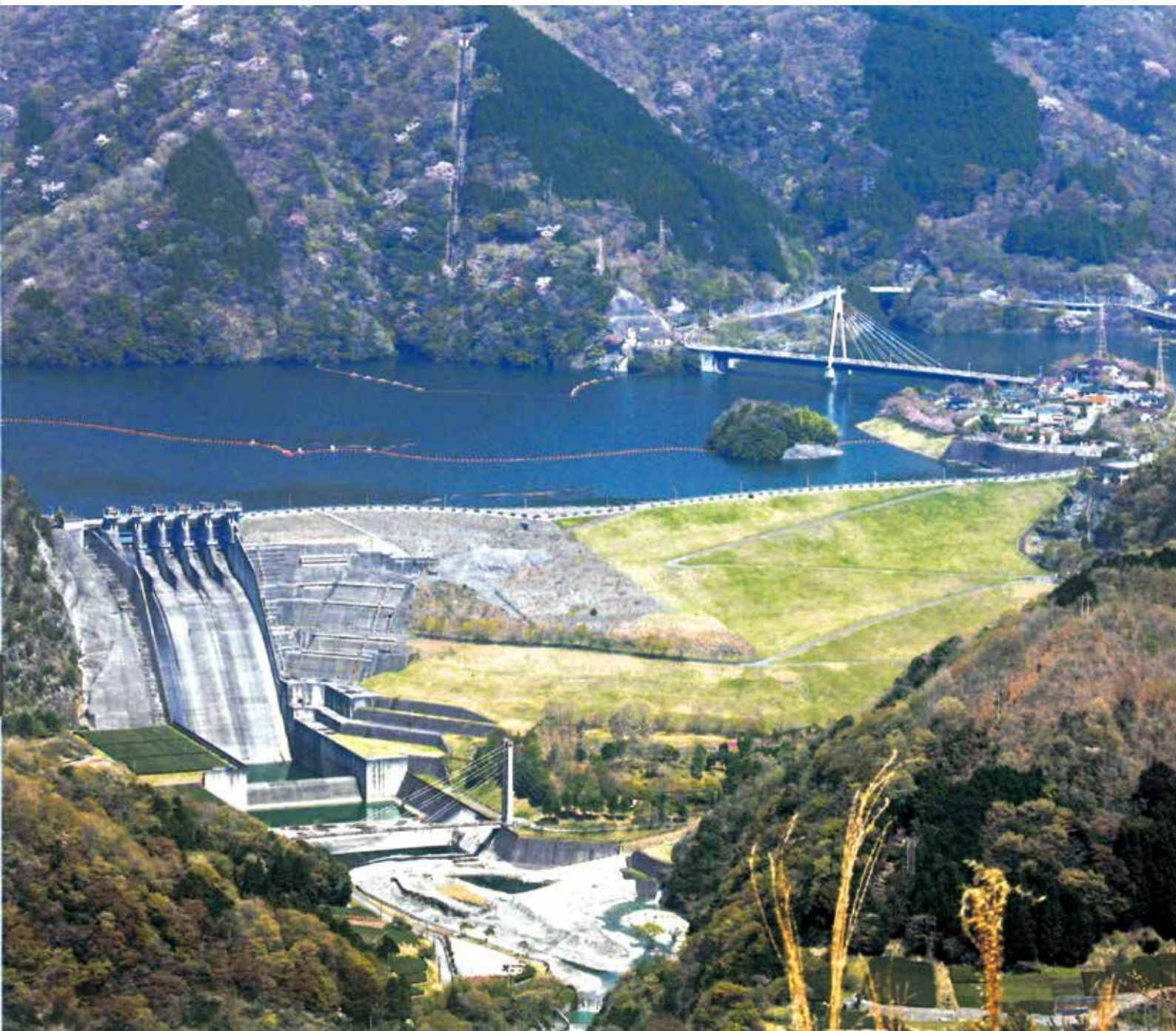
下流側から見た三保ダム
