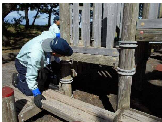
遊具の点検調査状況 (葉山公園)
