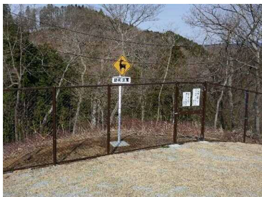
鹿の侵入防止柵 (山北つぶらの公園)
