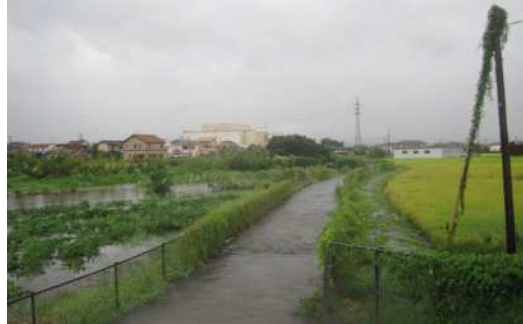
農業用水路の溢水状況 (令和元年台風第19号)
