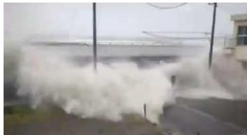
小田原海岸における越波の状況
