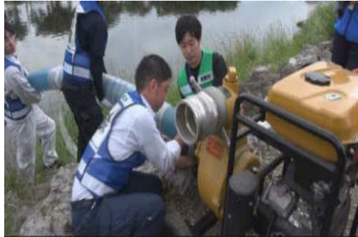
資機材整備の例（排水ポンプ）
