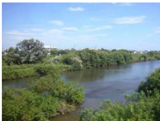
河床掘削・樹木伐採の実施
