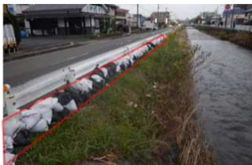
嵩上げコンクリート工事の実施
