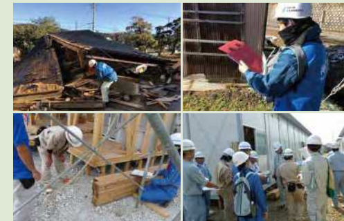
中：被災建築物の応急危険度判定業務/二次災害を防ぐ目的で被災建築物に被災地入り迅速な判定を行います。下：応急仮設住宅の提供業務。
