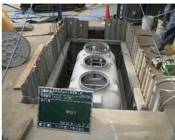
一般家庭への浄化槽設置 (相模原市)
