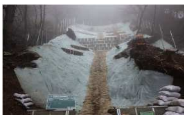
水源林の基盤整備
