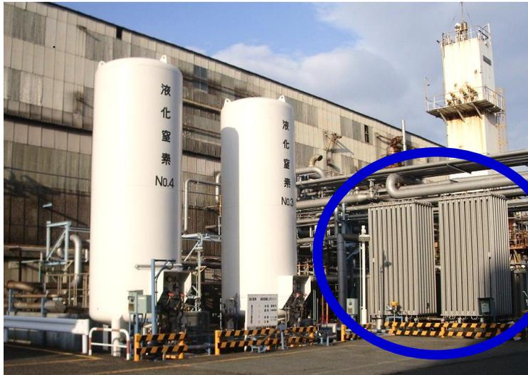
空気式液体窒素気化器
