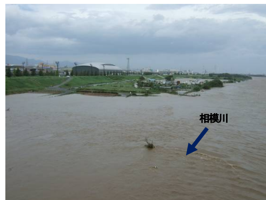
平成 19 年台風 9 号 相模川（平塚市）国直轄管理区間
