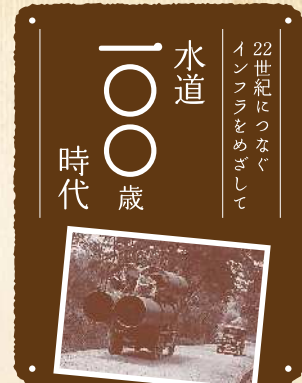
▲写真：水道管を運ぶ様子(昭和初期、湘南地方)
