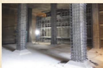
配水池内の柱を鉄筋で補強した様子（この後、コンクリートを打設して補強工事の完成）
