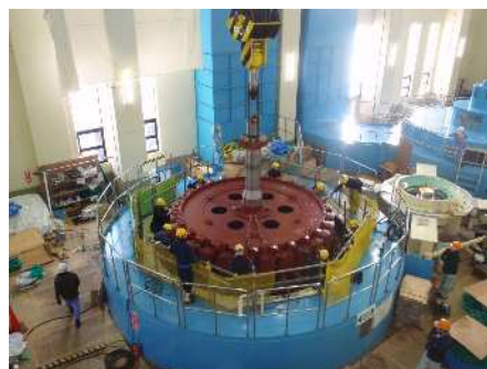
水力発電所のオーバーホール（津久井発電所）
