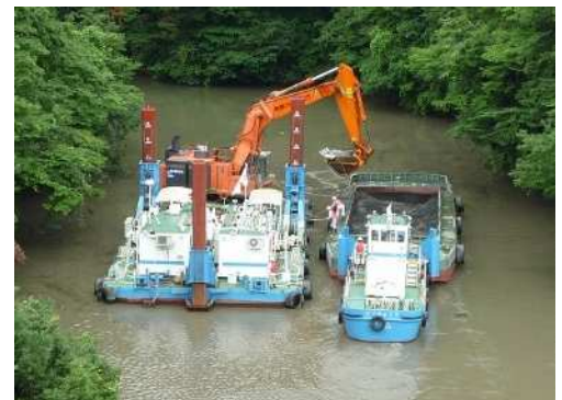
相模貯水池のしゅんせつ作業 (しゅんせつ船による湖面からの掘削作業)
