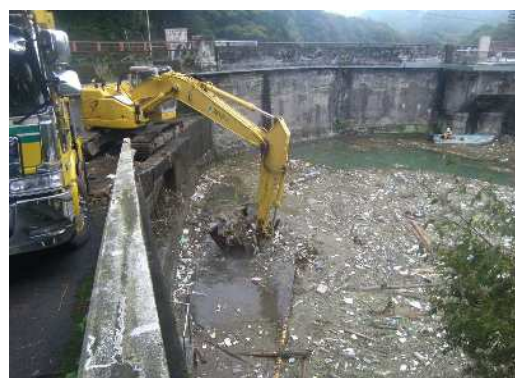
相模ダムに漂着した流芥引き揚げ作業
