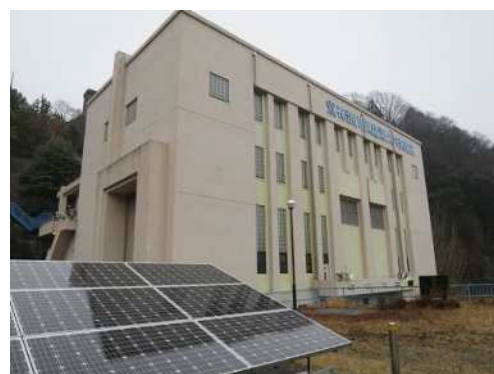
津久井発電所（水力発電所）
