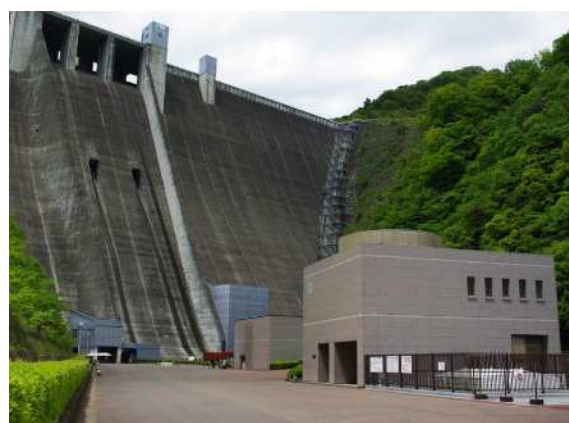
愛川第1発電所
