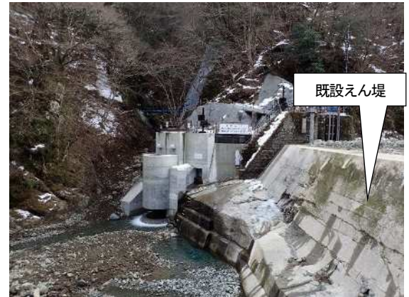
既設えん堤を再利用した小水力発電所（早戸川発電所）
