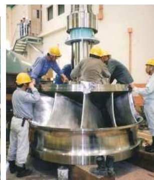
水力発電所のオーバーホール（津久井発電所）
