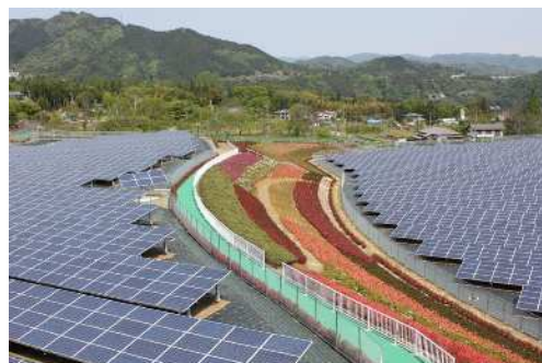
愛川太陽光発電所のつつじ庭園
