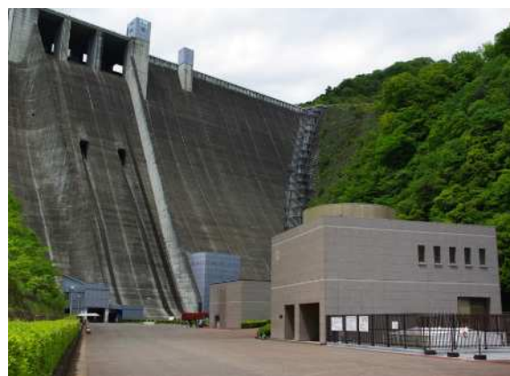
愛川第1発電所
