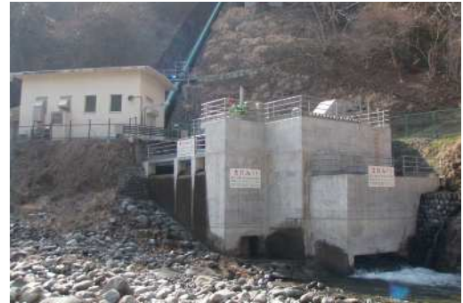
道志第 4 発電所（写真右側）
