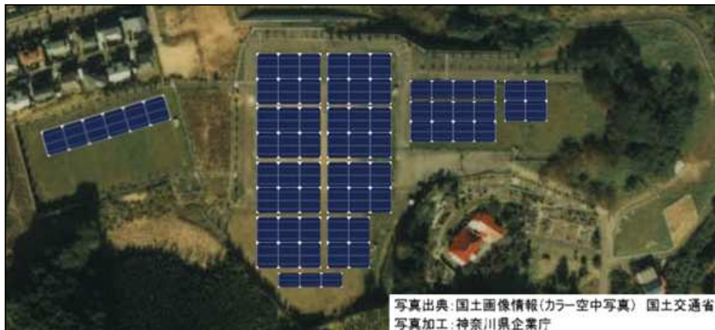
谷ヶ原配水池の上部を利用した太陽光発電所(イメージ) 工事期間(H25～H26年度)
