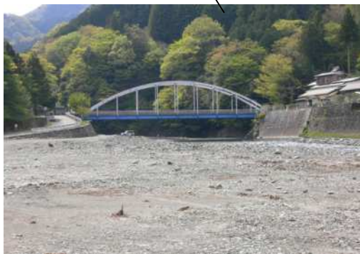
堆砂状況 ア（下流から大川原橋を臨む）
