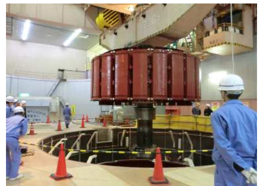
水車発電機のオーバーホール（城山発電所）
