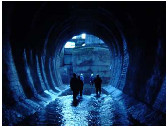
津久井導水路 (分水池側)
