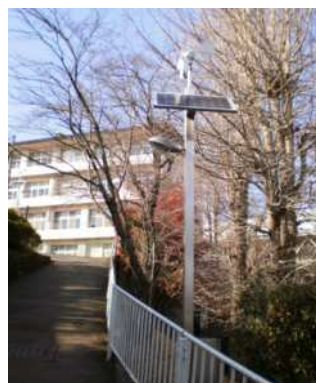
小学校に設置した太陽光・風力併用型街路灯
