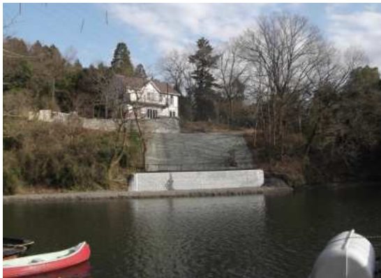
相模貯水池護岸工事
