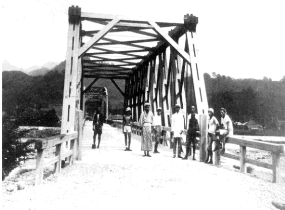
写真-1 平山橋完成時の写真（木橋と思われる）
