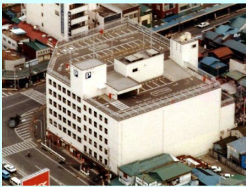
平塚市紅谷町立体駐車場
