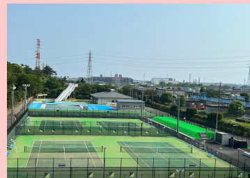
寒川町営プール・テニスコート
