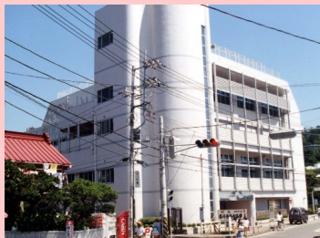
湯河原町スポーツセンター
