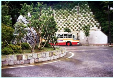
大山駐車場周辺自動車等折り返し広場
