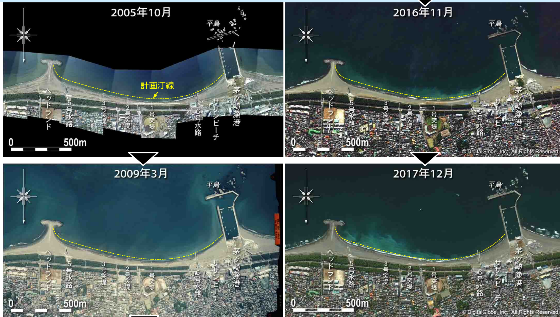
図3.2 空中写真による海岸の経年変化（2005年10月～2017年12月）
