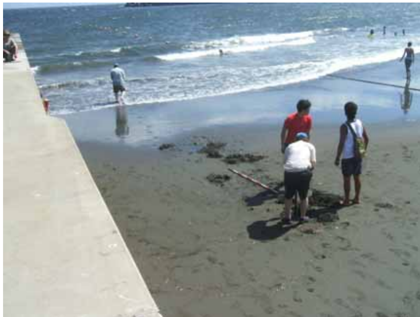
図-42 6号水路西側の掘削調査の様子 (2010年7月16日)
