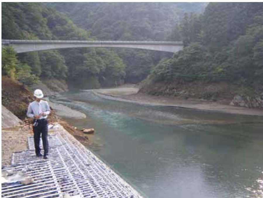
図-c 平成22年10月 宮ヶ瀬ダム浚渫箇所
