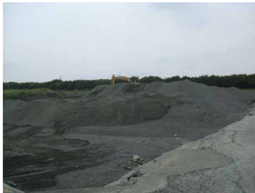
図- c 平成21年9月 茅ヶ崎市シールド工事発生土砂
