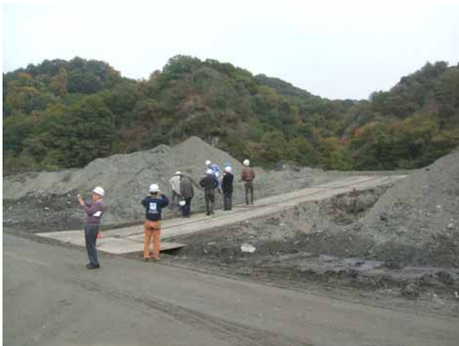
図- b 平成21年11月 相模ダム浚渫土砂
