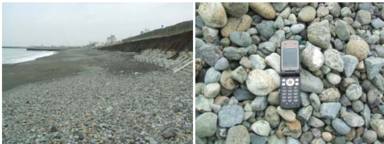
図- 30 平成20年6月 養浜後に堆積した礫
