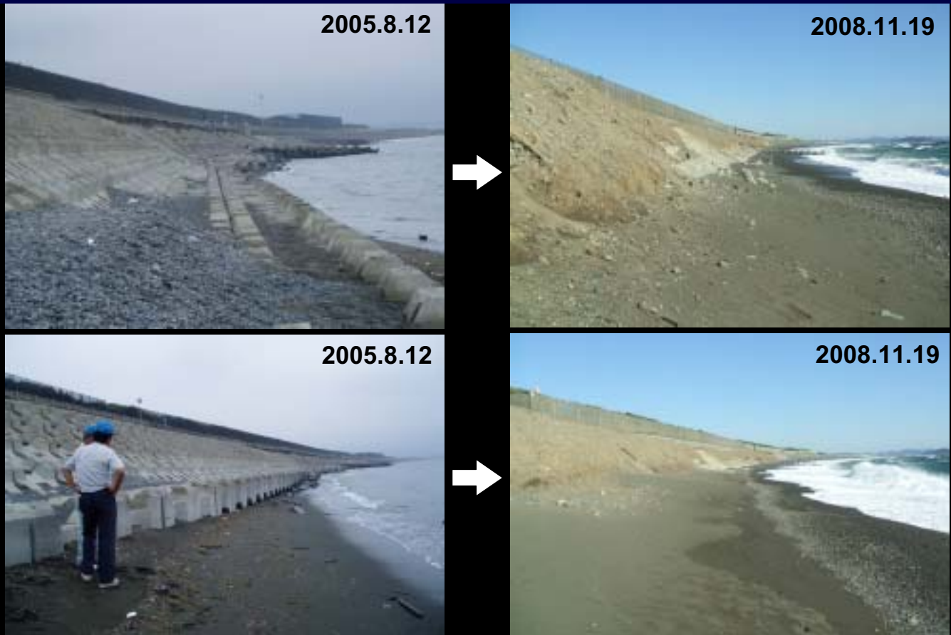
図- 24 定点写真による海岸の変化
