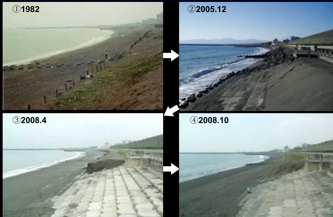
図- 25 定点写真による海岸の変化
