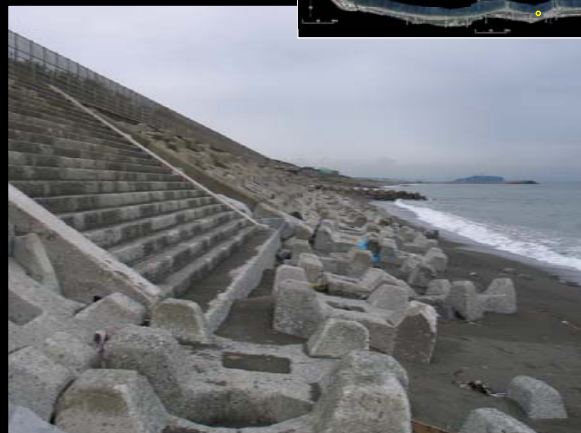
Photo 25 砂層厚変化の追跡調査を行っている階段下の状況
