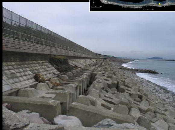
Photo 27 養浜砂の流出状況
