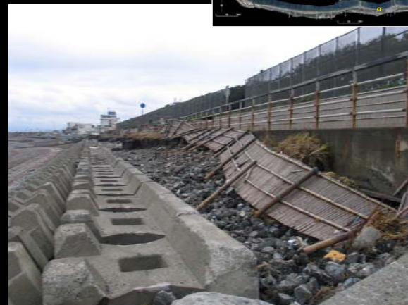
Photo 26 倒壊した堆砂垣
