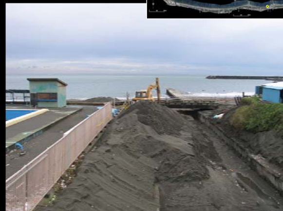
Photo 20 海水浴場(サザンビーチ)の隣に流入する6号水路への堆砂
