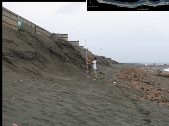
Photo 17 消波堤東端部と茅ヶ崎漁港間の中央部における浜岸形成状況
