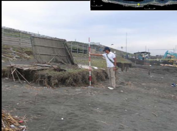
Photo 41 地引網の入口の斜路の修復地点における約0.6mと低い浜岸
