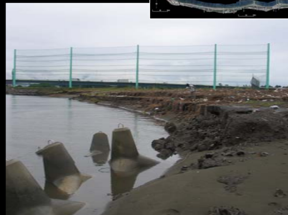
Photo 10 相模川河口左岸. 洪水流による側方侵食によって形成された崖
