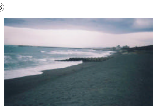
③ 砂浜が徐々に広がっており、養浜とヘッドランドによる効果が見られます。
