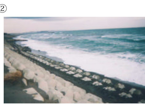
② 中央部では波が激しいため海岸を防護しているブロックの前面の砂浜はほとんど見られない状況でした。
