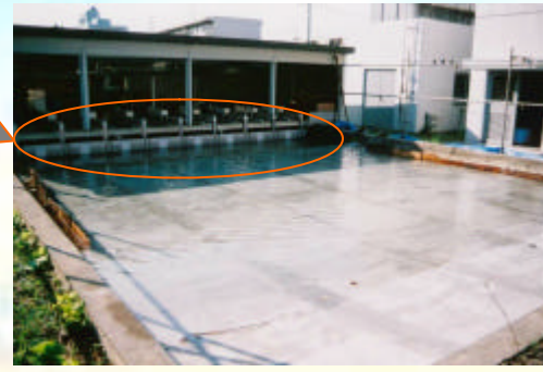
平面実験水槽 縦(岸沖方向)13m×横(沿岸方向)9m
