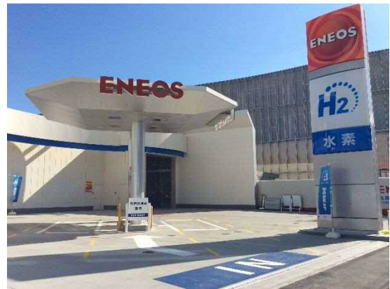
横浜綱島水素ステーション
