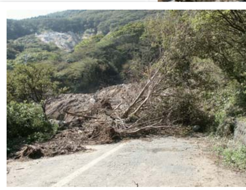
H14.10.11 撮影 道路を流れた土石流
