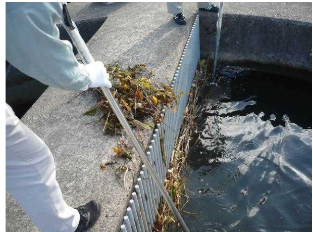
除去作業状況
