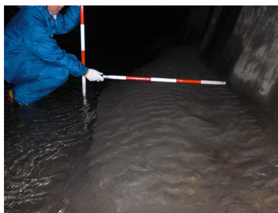
参考図 文命用水における堆砂状況(左:福沢第一発電所、右:文命隧道)
