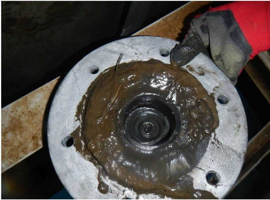
軸受け撤去状態
