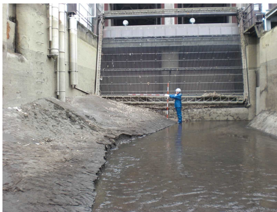
参考図 文命用水における堆砂状況(左:福沢第一発電所、右:文命隧道)
