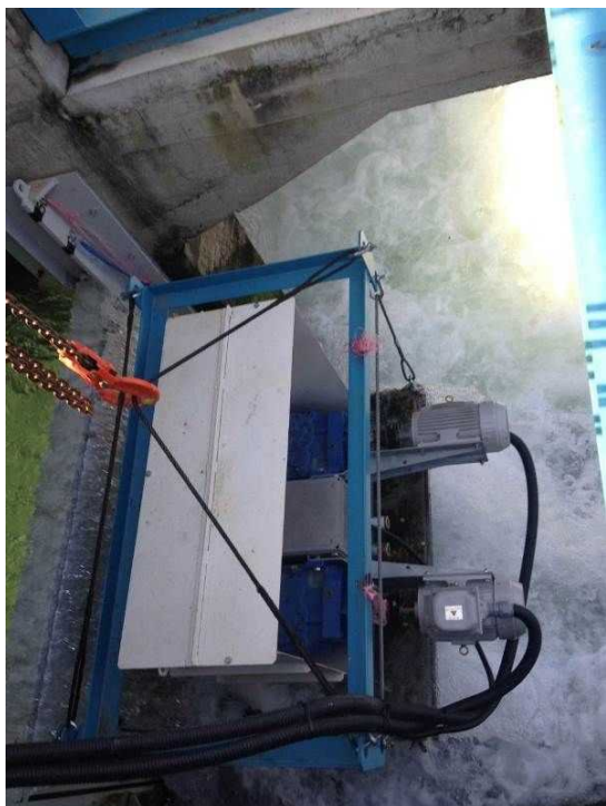
設備全景・越流部のゴミ等の付着確認
