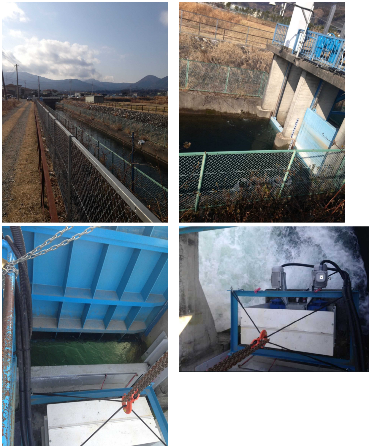
図-2.6 ゴミ等の障害物の浮遊状況(モニタリング時定点観測)
