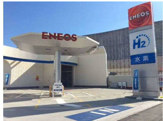
横浜綱島水素ステーション
