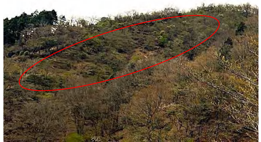
23年後の山腹工事施工地 令和5年（2023）4月19日
