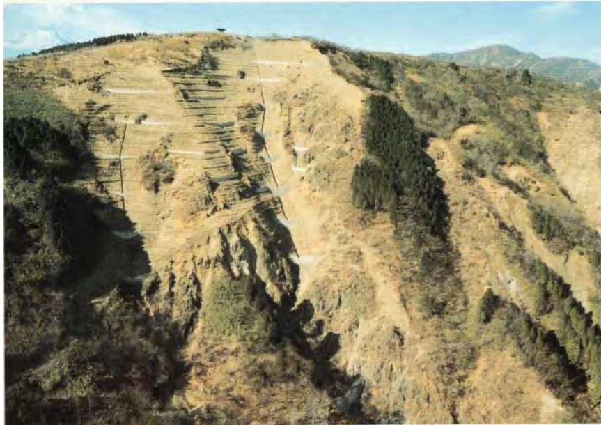
三ノ塔直下の基盤工事と初期緑化が完成した状況 昭和63年（1988） 復旧状況（三ノ塔）落合千秋氏撮影
