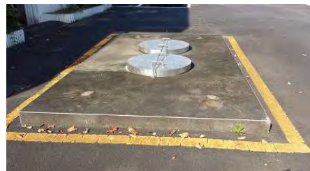
地下タンク地上部(例)
