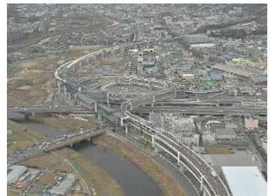
高速横浜環状北西線 横浜港北ジャンクション
