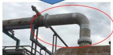
○フレアスタック（耐震補強工事）
