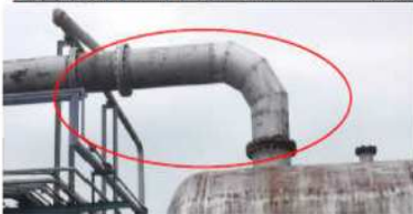
配管取り替え（マイターエルボ → 一体型エルボ）
