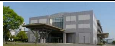
総合防災センター
