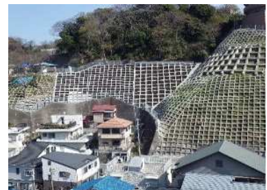
急傾斜地崩壊防止施設 (横須賀市吉倉町2A)
