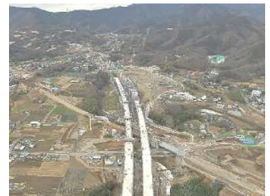
新東名高速道路 伊勢原大山インターチェンジ
