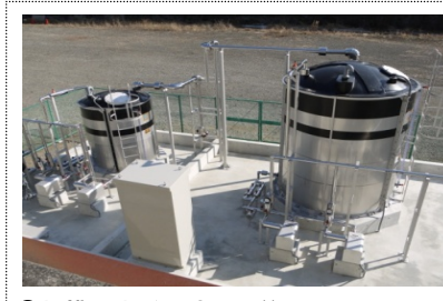
③ 相模川水系上流域対策 山梨県内の下水処理場に新たに設置したリンを取り除くための設備を稼働した。（山梨県桂川清流センター）
