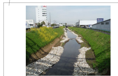
⑥ 河川・水路における自然浄化対策 自然石による護岸とし、生物の生息空間を確保した。（厚木市恩智川）
