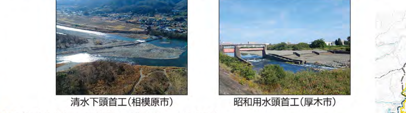
清水下頭首工(相模原市) 昭和用水頭首工(厚木市)
