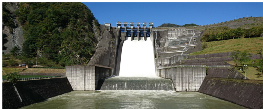
ダムゲートからの放流
