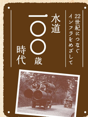
▲写真：水道管を運ぶ様子（昭和初期、湘南地方）
