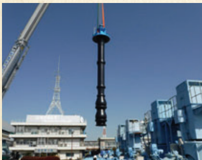
送水ポンプの工事の様子
