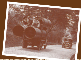
▲写真：水道管を運ぶ様子（昭和初期、湘南地方）
