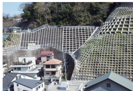
急傾斜地崩壊防止施設 吉倉町2丁目A(横須賀市)
