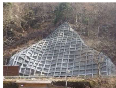
神の川林道 法面保護工(相模原市)
