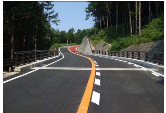
トラックやバス等大型車両の通行も可能となった農道
