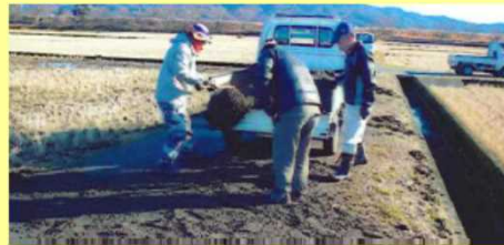
農道整備作業の様子
