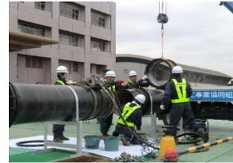
管工事組合による水道管の漏水修理訓練
