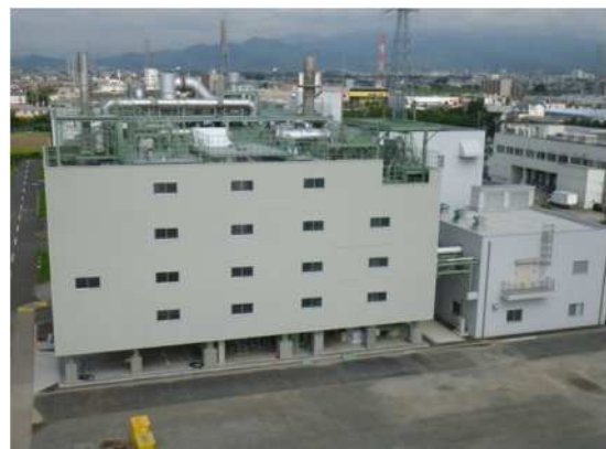
北系2号汚泥焼却設備 全景
