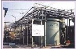
2 除害施設 工場、事業場排水の中には、下水管をつまらせたり、下水処理に悪影響を与えるものがあるので、そのような有害物質を取り除きます。
