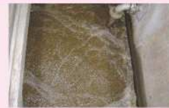
6 反応タンク さらに水をきれいにするため、活性汚泥という微生物の凝った形を加えて、反応タンクの底から空気を送り込みます。微生物は下水の汚れをエサにして繁殖し、糞のようなかたまりとなって沈みやすくなります。
