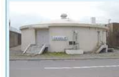
12 汚泥濃縮設備 最初沈殿池や最終沈殿池で底に沈んだ汚泥が集められ、濃縮し水分を減らします。
