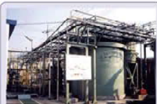
② 除害施設 工場、事業場排水の中には、下水管をつまらせたり、下水処理に影響を与えるものがあるので、そのような有害物質を取り除きます。
