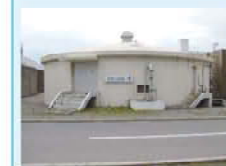
⑰ 汚泥濃縮設備 最初沈殿池や最終沈殿池で底に沈んだ汚泥が集められ、濃縮し水分を減らします。
