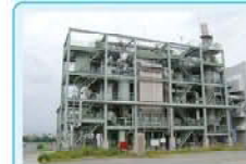
⑮ 汚泥焼却炉 有機物を食んだ脱水汚泥をこの焼却炉で燃やすと灰になり、減量されます。
