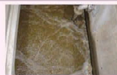
⑥ 反応タンク さらに水をきれいにするため、活性汚泥という微生物の混ざった泥を加えて、反応タンクの底から空気を送り込みます。微生物は下水の汚れを食べて繁殖し、綿のようなかたまりとなって沈みやすくなります。
