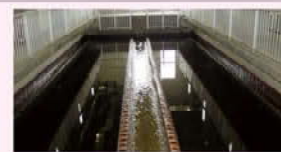
⑦ 最終沈殿池 最終沈殿池で水をゆっくり流すと、綿のようなかたまりとなった活性汚泥が、水の底に沈み、水はすっかりきれいになります。沈んだかたまりは反応タンクへもどされ、ふたたび下水の浄化に利用されます。なお、汚れを食べて増えた活性汚泥は余剰汚泥といい、汚泥濃縮設備へ送られます。
