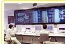
⑬ 中央監視室 下水量や汚泥量の変化に応じて適切な処理ができるように、常時処理施設の運転状況を監視しています。
