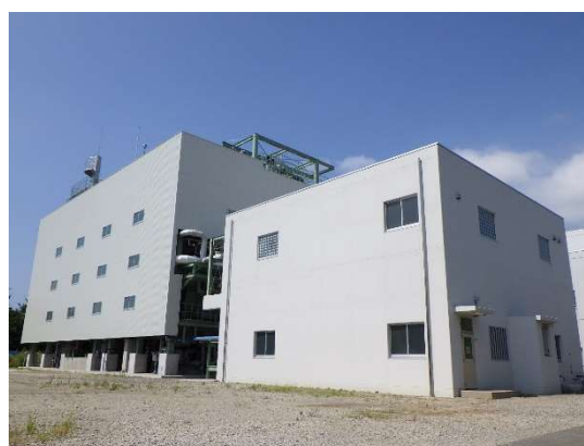
北系3号汚泥焼却設備 全景
