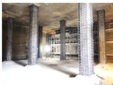
配水池耐震化工事
