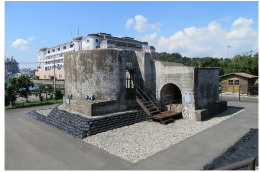
東京湾第三海堡構造物（観測所）
