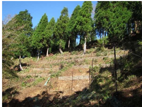
（写真）間伐・植生保護柵等の森林整備を行った箇所（清川村）
