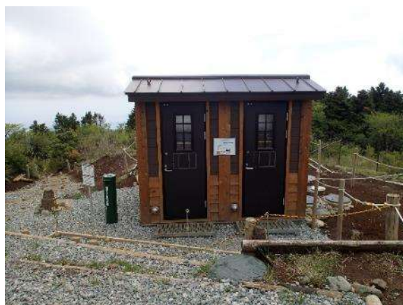
(写真) 三ノ塔山岳公衆便所（平成29年度設置）
