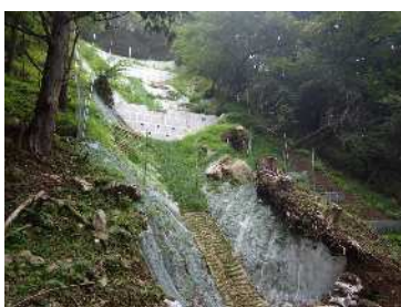
水源林の基盤整備
