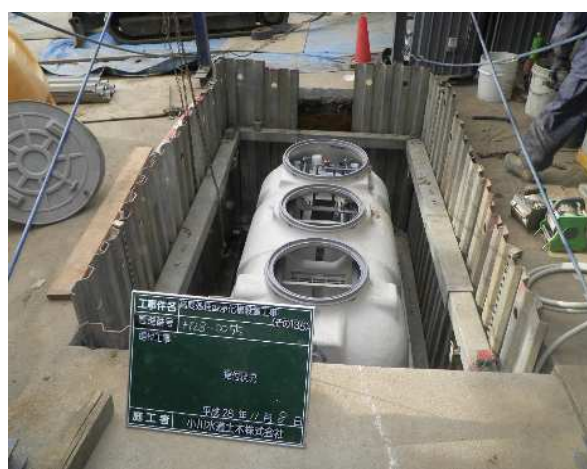
一般家庭への浄化槽設置（相模原市）
